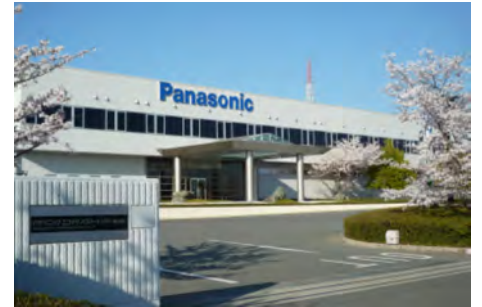
図1 パナソニックエコテクノロジーセンター外観
